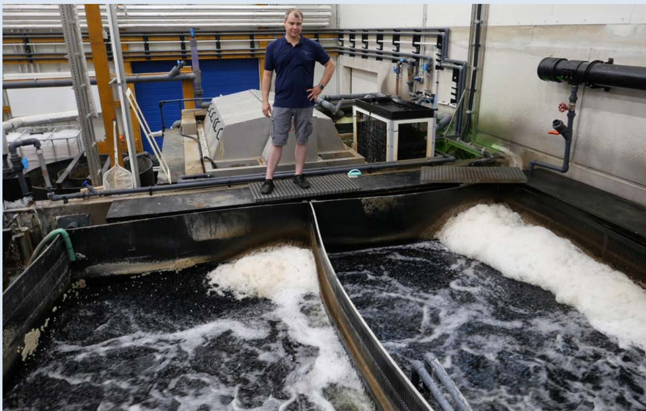
Max Hoersen erklärte auch die Wasserzirkulation in der Klärtechnik. Im Vordergrund sind zwei der insgesamt vier Biofilter und hinter ihm der Trommelfilter zu sehen.
